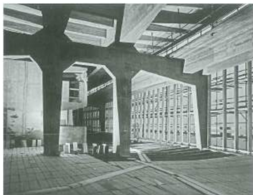
Interno del Grattacielo Pirelli in costruzione.
