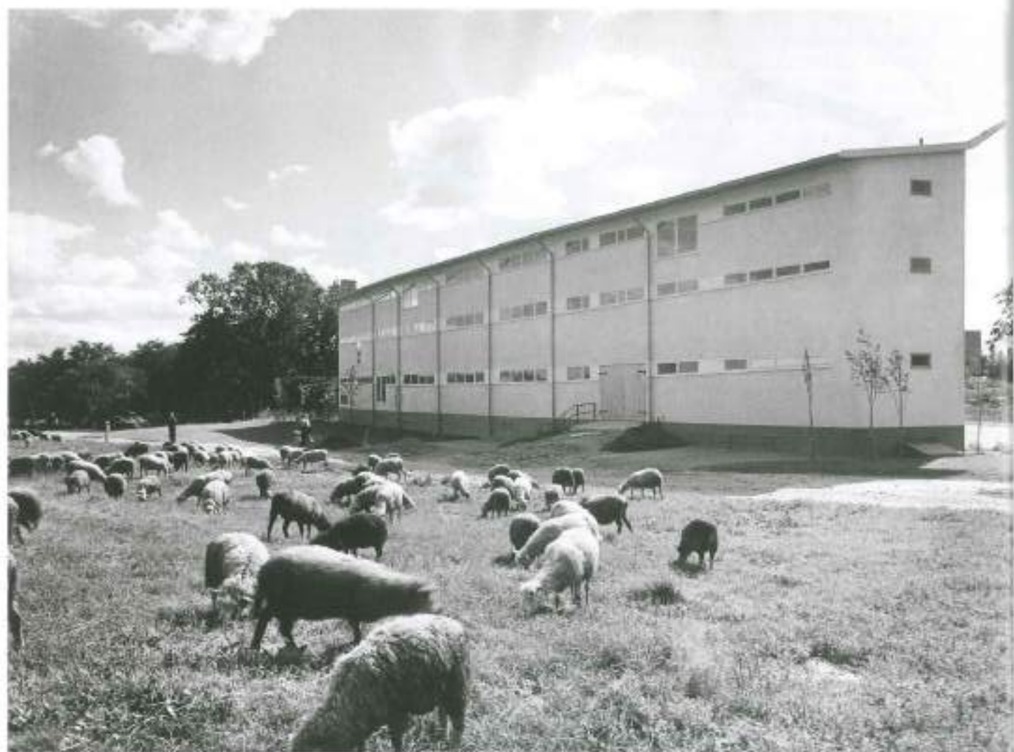
Qui sopra: Istituto italiano di cultura (1954); Stoccolma.
